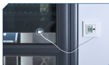
Capteur soleil/ crépuscule (câble de 1,50 m)
