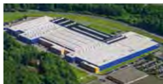
Hörmann KG Eckelhausen, Allemagne
